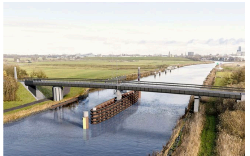
DRIVE, de biobased fietsbrug over het Van Harinxmakanaal
